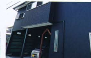
外壁はガルバリウム鋼板でシャープな印象。屋根に断熱材を施工しているため、断熱性も高い
